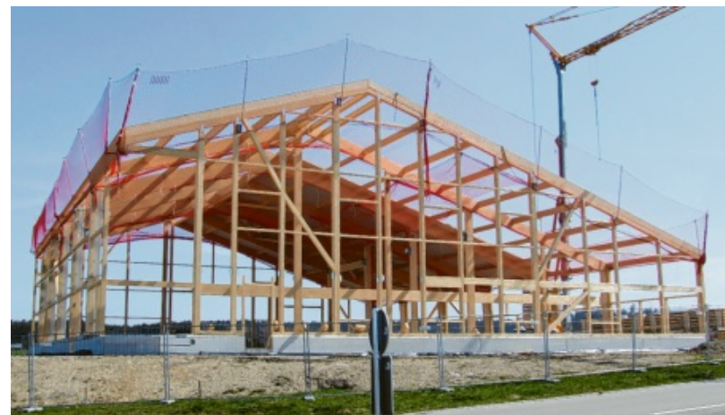
Die neue Abbundhalle der Zimmerei Leonhard Brecheisen im Fischbacher Gewerbegebiet Weite Eiche II ist schon von Weitem zu sehen. Foto: Siegfried P. Rupprecht
