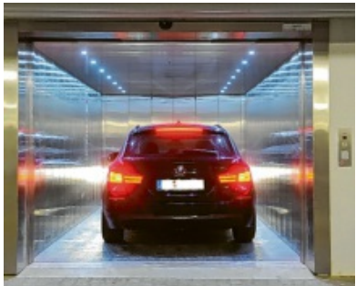
Bei der Schaffung des Auto-Aufzuges äußern einige Gemeinderäte in Gessertshausen Bedenken. Foto: Uli Deck, dpa
